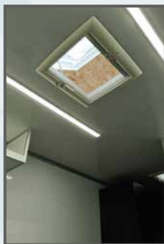
Fenêtre aération de toit
